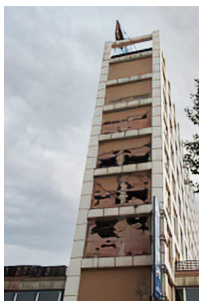
图5 单跨框架（钢筋混凝土）
