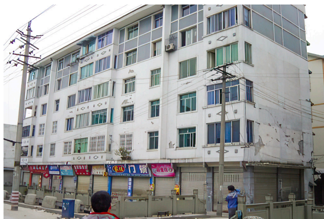
图3 底层框架—抗震墙
