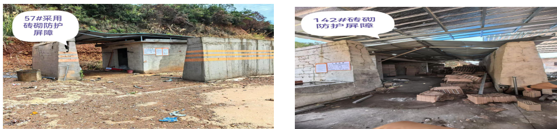
图 5 防护屏障采用砖砌结构
